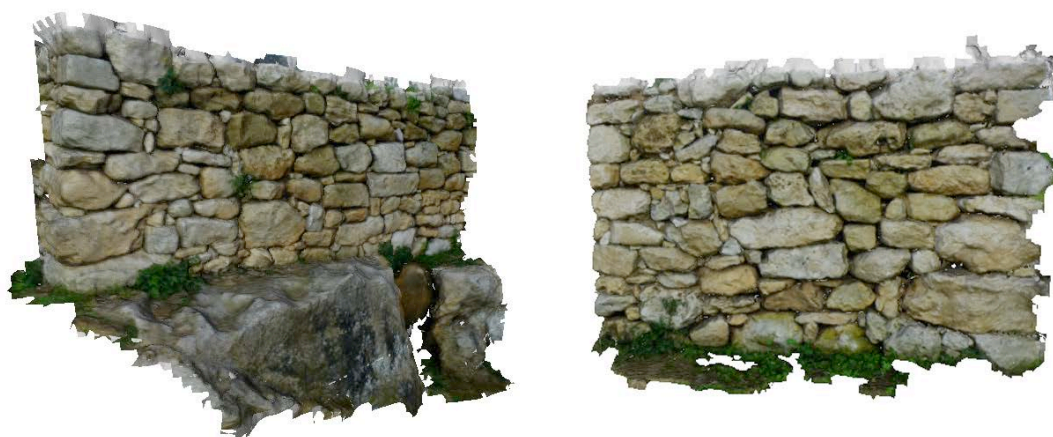
Fig. 5: Restituzione 3D mediate tecniche image-based di un muro a secco
