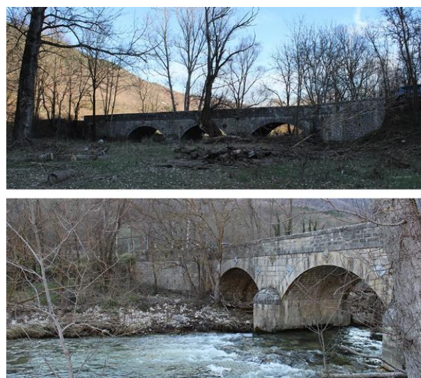
Fig. 2: The Ponte delle Tavole in Fontecchio (AQ)
