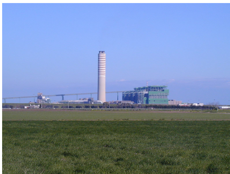
Figura 14: La centrale policombustibile “Federico II”, a Cerano, 12 Km a sud di Brindisi.
